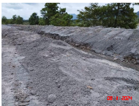
รูปที่ 3 คั่นทำนบดิน และคูระบายน้ำ
