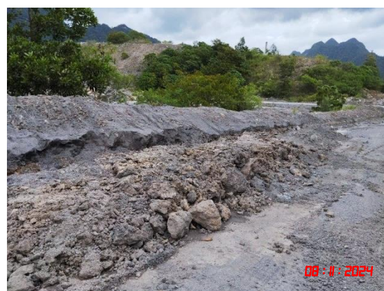
รูปที่ 3 คั่นทำนบดิน และคูระบายน้ำ
